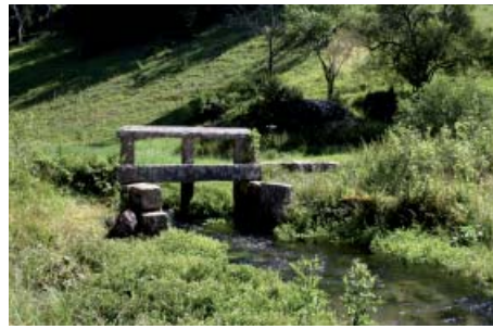
Reste der historischen Bewässerungsanlage, dem sogenannten „Schwall“
