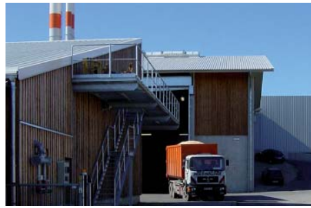
Hackschnitzelanlieferung am Biomasse-Heizkraftwerk
